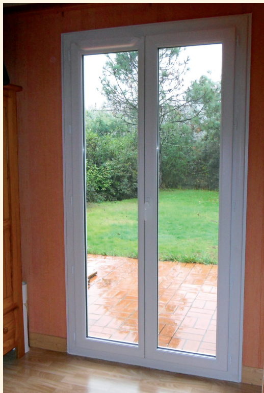
Une fenêtre acoustique installée
