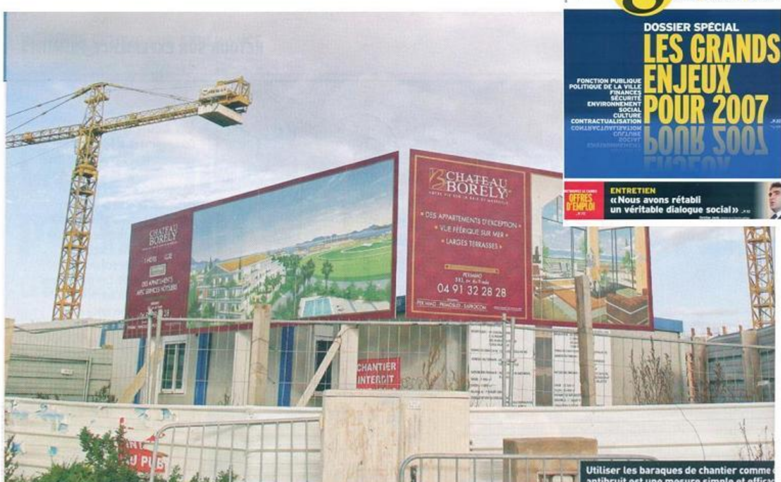
Utiliser les baraques de chantier comme antibruit est une mesure simple et efficace
