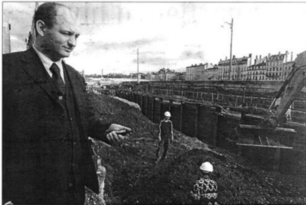
Depuis près d'un an, la société Synesthésie gère de façon permanente le niveau sonore du chantier de la place Benoit-Crépu, en effectuant tout au long de la journée, des mesures acoustiques. Ces mesures atteignent en moyenne des valeurs comprises entre 78 et 80 dB, ne dépassant que légèrement le niveau sonore habituellement relevé place Benoit Crépu, de 75 dB. (Photo Marcos)
